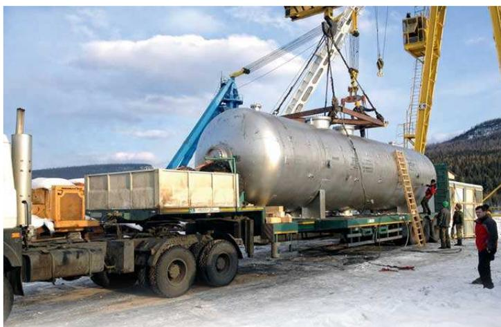
Рисунок 3.2 - Погрузка негабаритного груза
